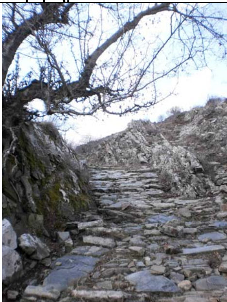
Φωτογραφία αρ. 1. Τμήμα οδοστρώματος στο 6 ο χιλιόμετρο.
