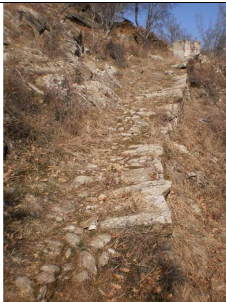
Φωτογραφία αρ. 2. Τμήμα οδοστρώματος στο 8 ο χιλιόμετρο.
