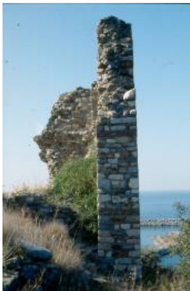
13. Βυζαντινός οχυρωματικός πύργος (σωζόμενο ύψος 14 μ.)
